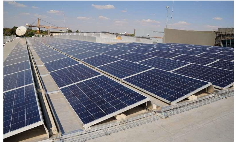
Generador ( \approx 1 MW)
