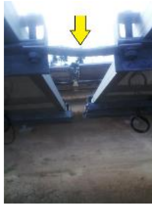
Figura 3: Interconexión de la malla de tierra entre mesas. Fuente: Elaboración propia.
