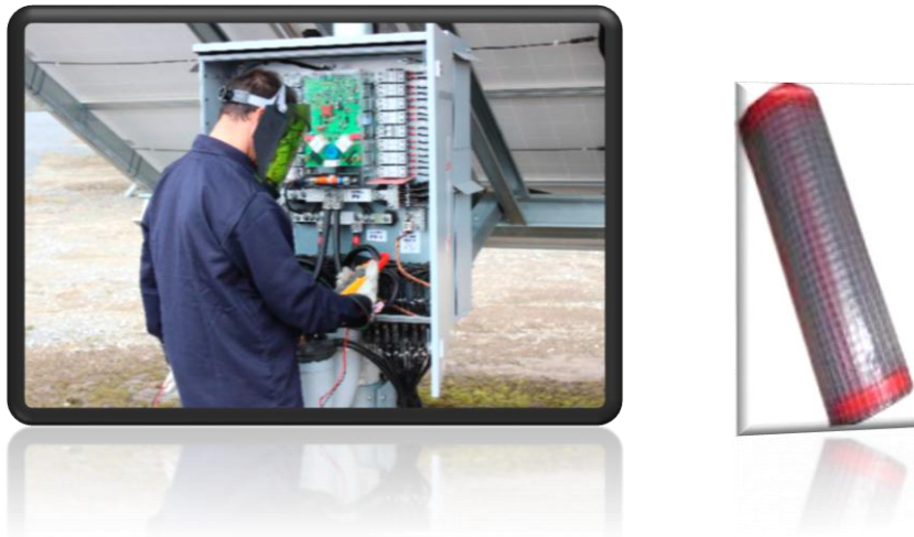
Figura 6: Medios de protección individual. Fuente: Internet.
