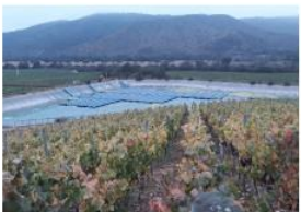
Bodega – Bombeo de autoconsumo (PPA) – Gran bodega – Leyda (Chile)
