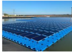
Agricultura – Bombeo solar directo- C.R. Guadiana (España)
