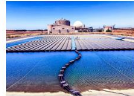
Tratamiento de agua – Conectado a la red – Hefer Magae (Israel)
