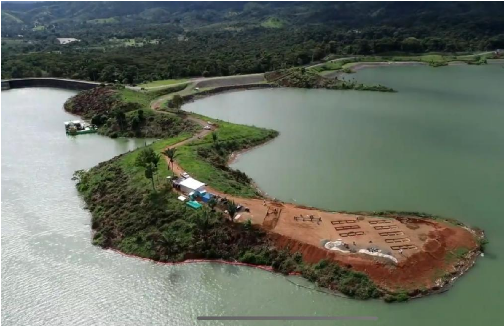
Estructuras en Tierra del Sistema Solar Fotovoltaico Complementario al Sistema Solar Fotovoltaico - 169 kWp
