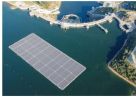
Hidroeléctrica – Conexión a Red – Alqueva (Portugal) – EDP
