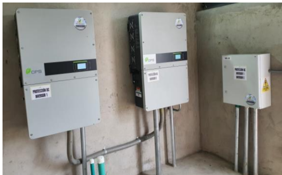
Instalación en Valledupar, Colombia Proyecto de 174.24 kWp 2 inversores de 60kW
