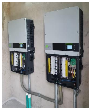
Instalación en Valledupar, Colombia Proyecto de 174.24 kWp 2 inversores de 60kW
