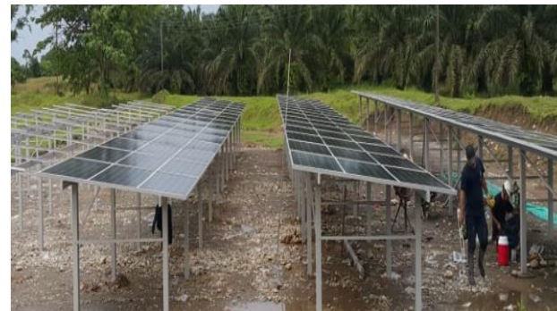
Instalación en Granada, Meta Proyecto de 99.9 kWp 2 inversores de 50kW
