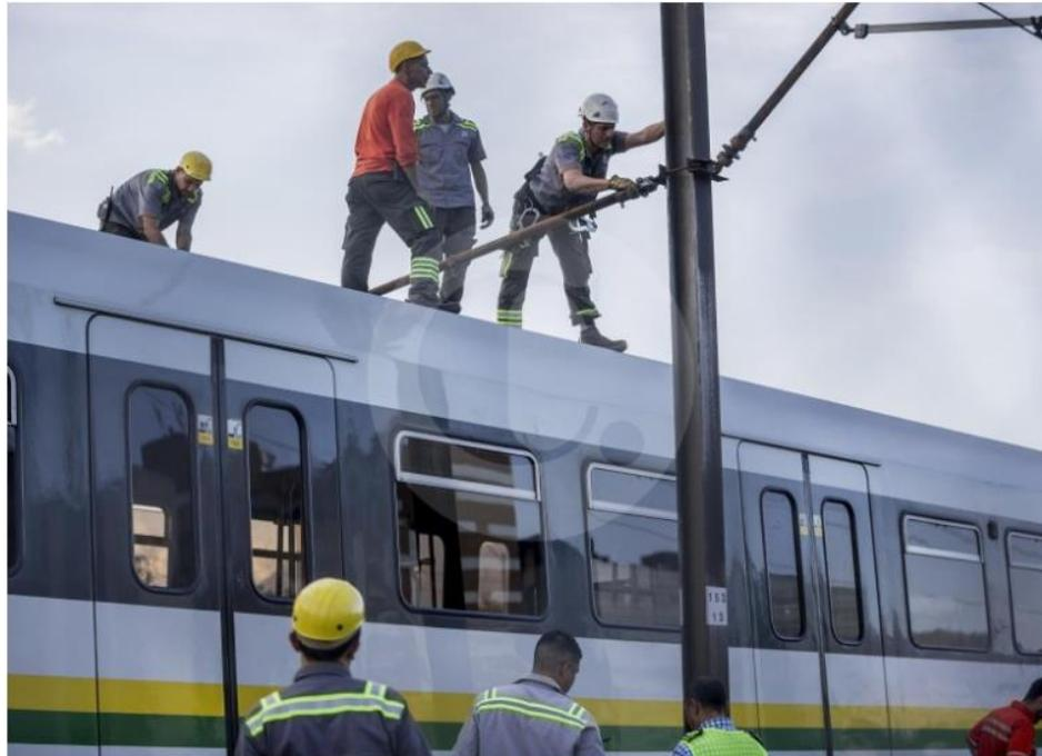
El sobrevoltaje obligó al Metro a tomar **medidas de mitigación** del riesgo ante la probabilidad de que vuelva a ocurrir. Desde entonces se inspeccionan de manera constante la catenaria y **los sistemas de puesta a tierra**, se monitorean con cámaras especializadas la temperatura de elementos y accesorios de la catenaria y se modificó la configuración de los pararrayos en las zonas afectadas.
