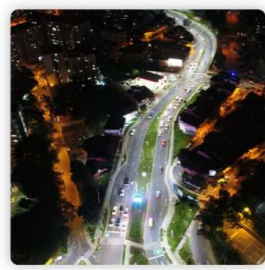
Envigado: Telegestión de luminarias LED en sus vías principales
