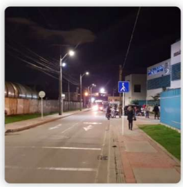
Funza, Cundinamarca: Modernización y Telegestión de luminarias
