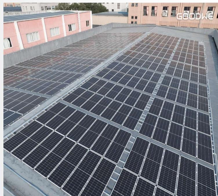
\* Aproximadamente 3,8 kg de estructuras de fijación adicionales por panel solar, añadiendo aproximadamente un 13,6% del peso total de los módulos fotovoltaicos convencionales al peso final del generador fotovoltaico.
