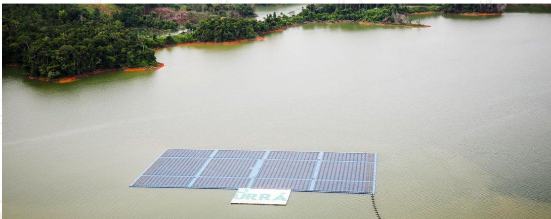
Proyecto piloto de planta solar flotante "Aguasol", Córdoba – 1,52 MWp Fuente: Ministerio de Minas y Energía.
