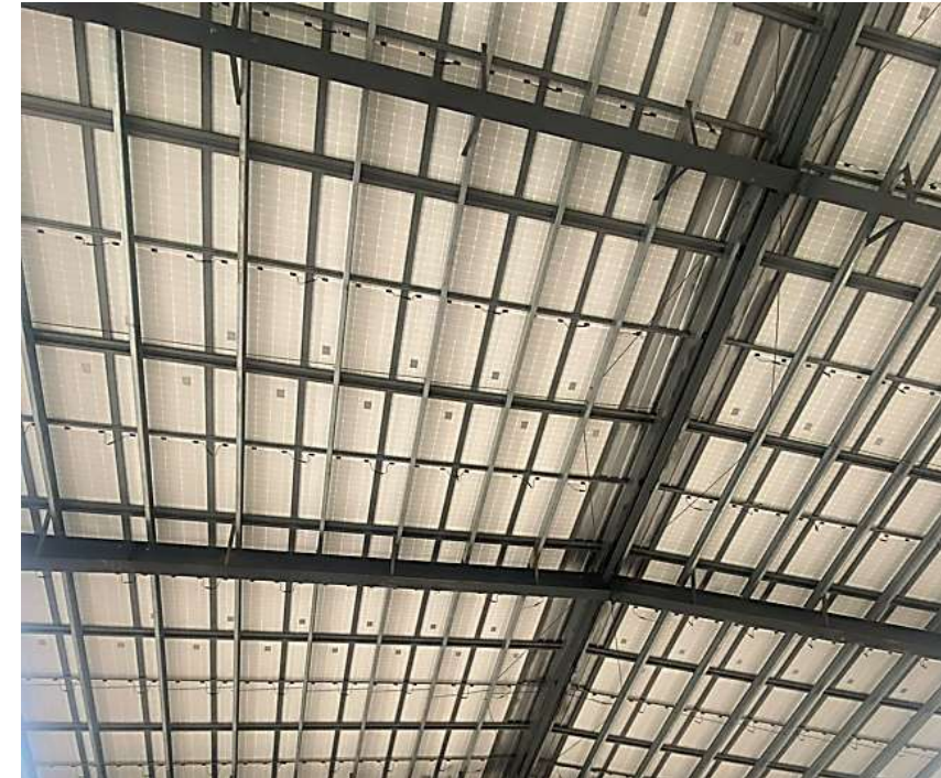
Q-CSI-S | 2022 - 980 kWp Piloto de Prueba
