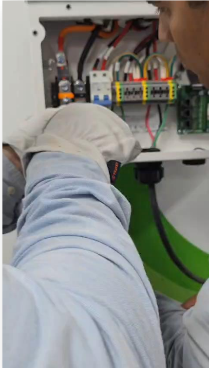
Paso 2: Conexiones ( AC, DC, AT, Respaldo )
